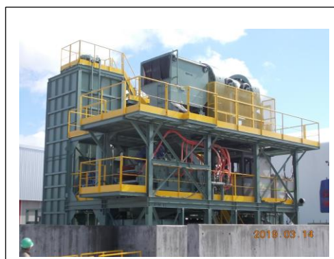
洗浄プラント工事中
